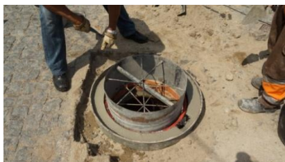
Enchimento do molde com SecilTEK Betão Rápido
