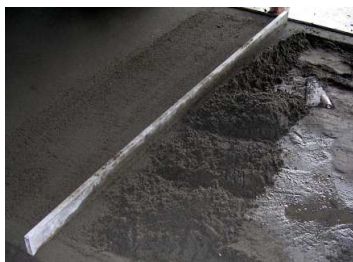
Colocação da argamassa
