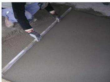
Regularização com régua metálica
