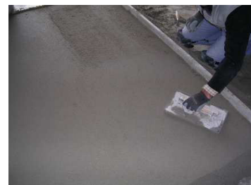
Talochamento da superfície final
