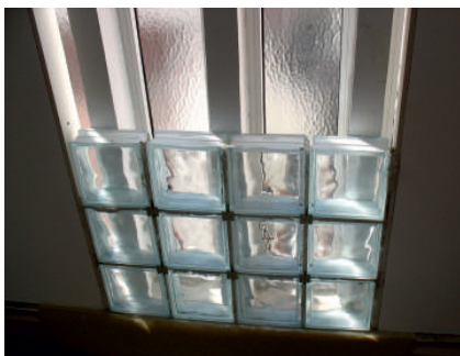
Montagem dos painéis de vidro
