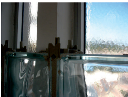
Colocação dos espaçadores
