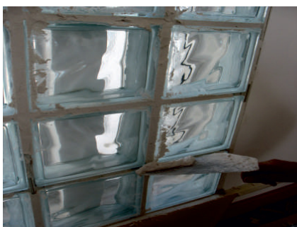
Preenchimento das juntas
