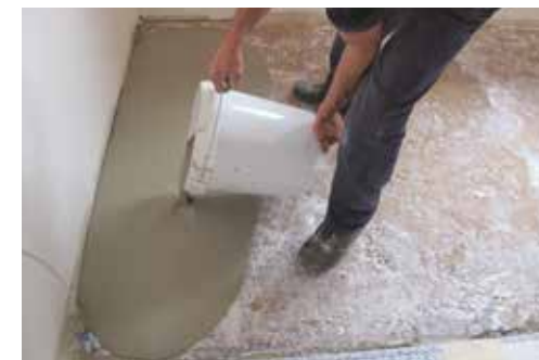
Aplicação do PLAN LEVEL 315
