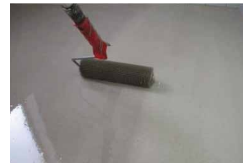
Uniformização da superfície c/ rolo de bico
